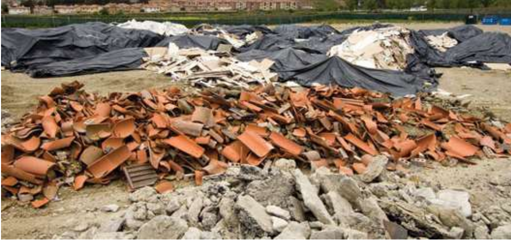
Ilustración 3 RCD'S clasificados. Fuente: www.constru-guia.com
